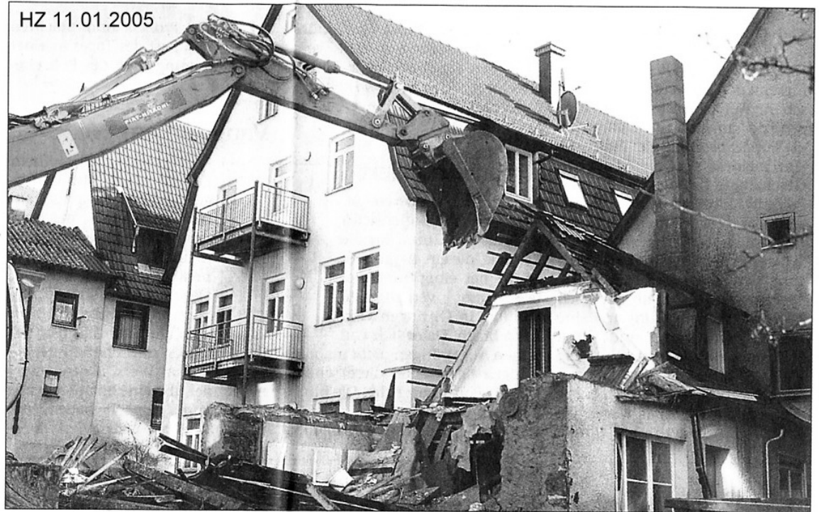
Die im Rahmen der Sanierung Altstadt III geplanten Abrissarbeiten der Gebäudezeile Bühlhofer Straße 3 bis 5 begannen am Montag. Hier beseitigt der Abrissbagger einen Anbau in der Seifensiedergasse. (Fotos: Henry Doll)
